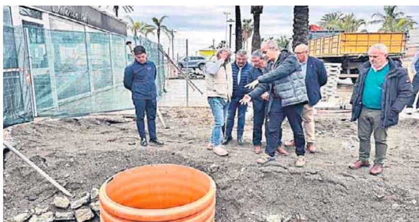
Lugar de las obras, en Torre del Mar
