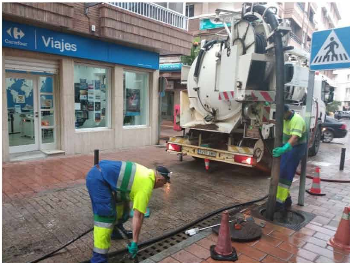
Trabajadores de Aguas y Servicios limpiando imbornales.
