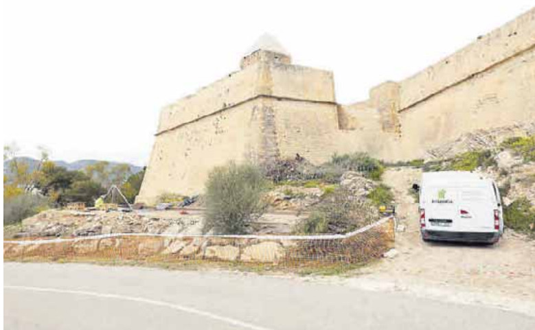
Operarios trabajan en la zona superior del depósito, ayer lunes.
